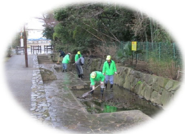
水路上流側のドロ除去作業
