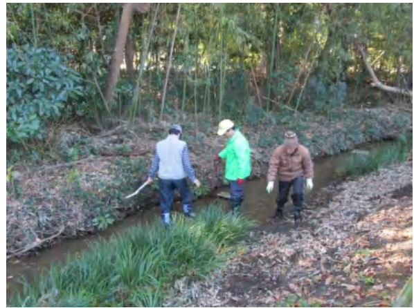
水路の整備中
