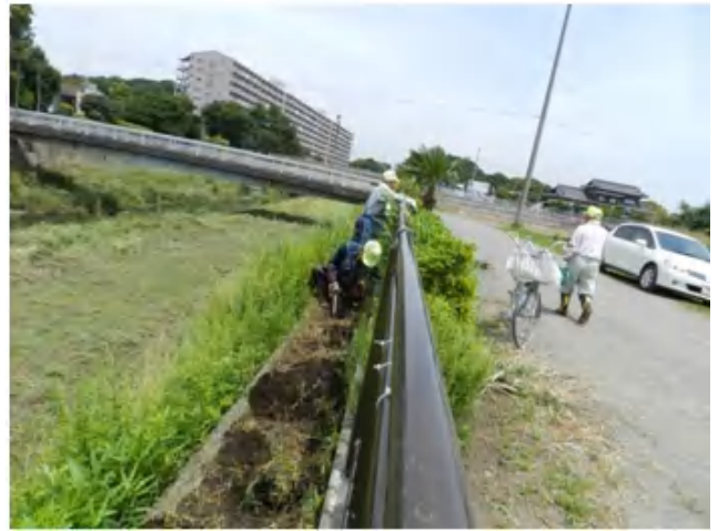
フェンスの両側を整備中
